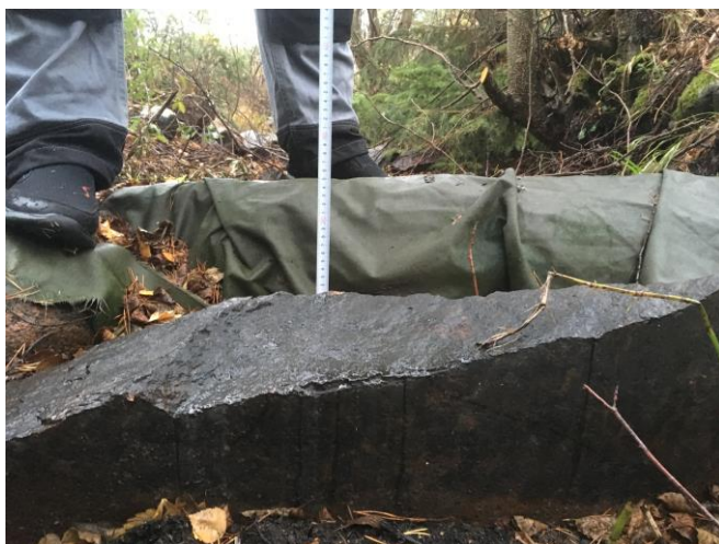
Uppdämningen är byggd av sten och presenning.
