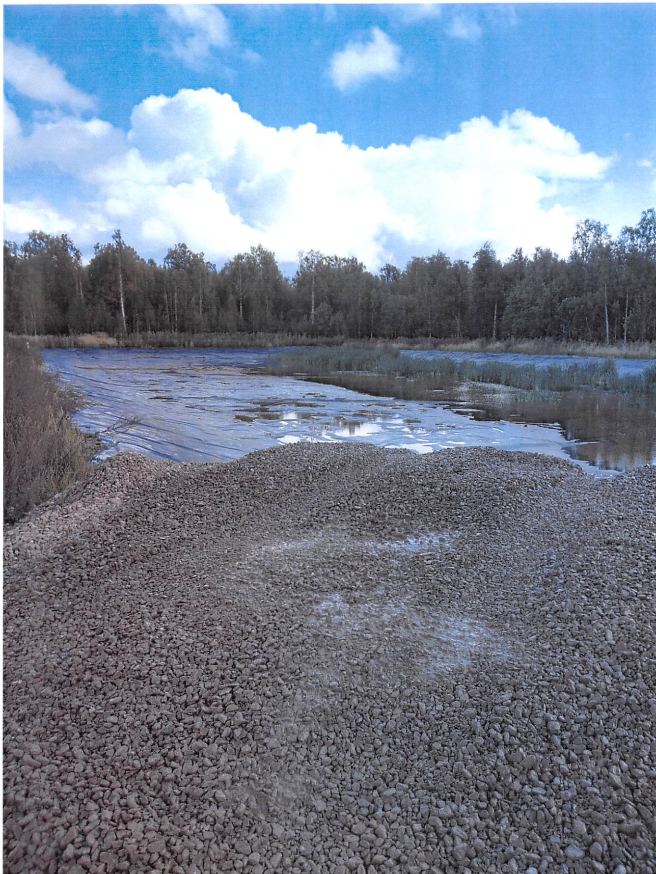
Figur 5 Grushög vid lakvattenbassäng
